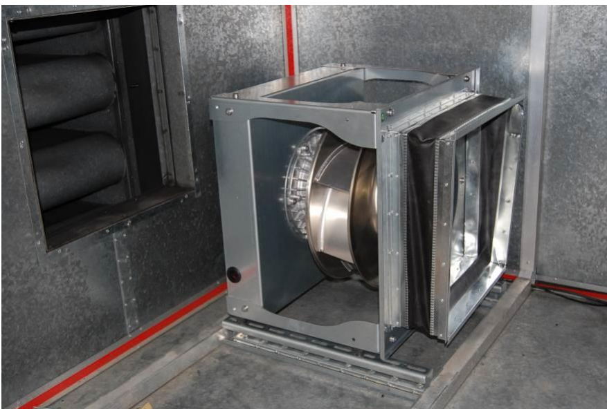
Bild 2: Die RadiPac EC-Ventilatoren von ebm-papst im RLT-Gerät.
