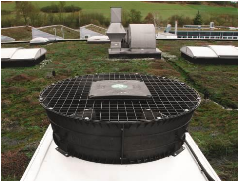
Bild 2: Der AxiTop® im Einsatz auf einem Wärmetauscher.
