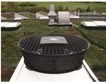
Bild 2: Der AxiTop® im Einsatz auf einem Wärmetauscher
