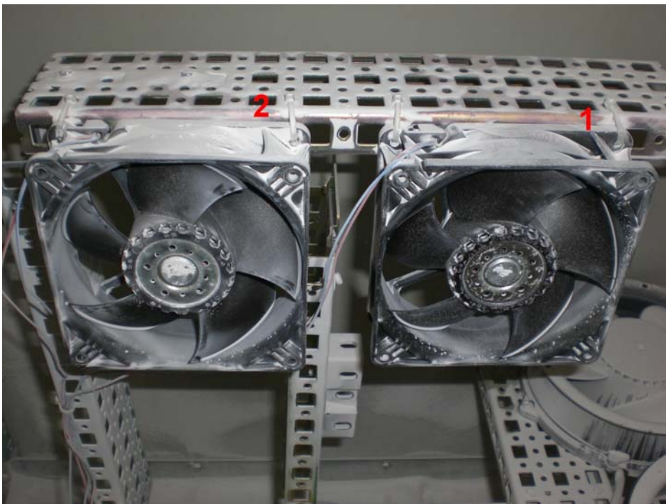
Bild 3: Modell 4400 mit schmutzabweisender Beschichtung reduziert Ablagerungen deutlich
