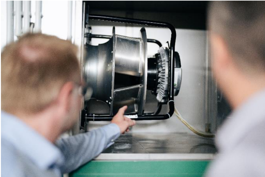
Bild 3: Die neuen RadiFit und RadiPac Ventilatoren sind dank EC-Motor deutlich sparsamer und konnten durch ihre Plug & Play Fähigkeit schnell und einfach ausgetauscht werden.
