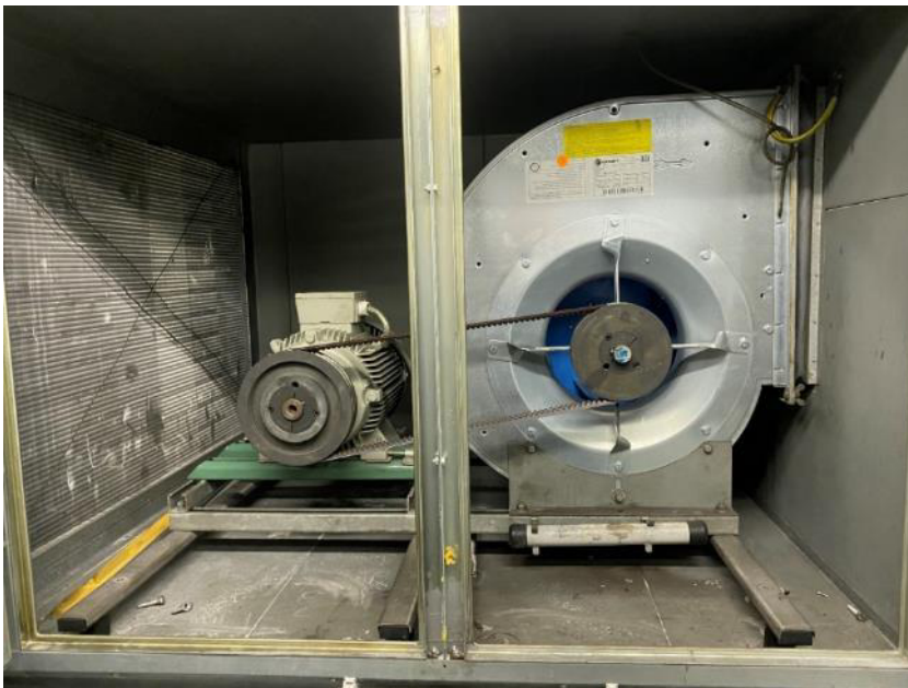
Bild 2: Die alten, riemengetriebenen Ventilatoren verbrauchten zu viel Strom und die Luftleistung war für neuere Anbauten nicht ausreichend.
