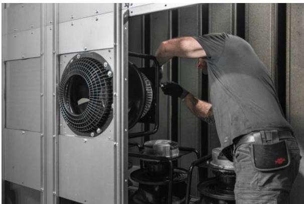
Bild 2a: Ein FanGrid mit mehreren parallel betriebenen Ventilatoren bietet eine hohe Betriebssicherheit.
