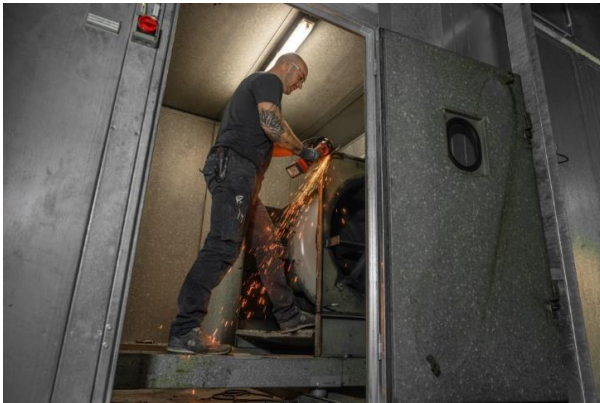
Bild 1: Die alten Ventilatoren waren zu groß, um sie in einem Stück aus dem Anlagenraum herauszutragen. Vorher mussten sie in Einzelteile zerlegt werden.
