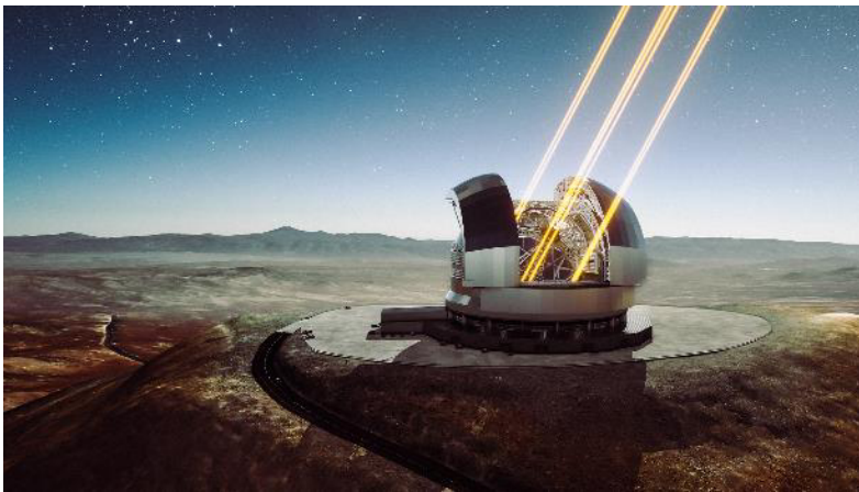
Bild 1: Bis zu acht sogenannter Leitstern-Lasersysteme werden dem ELT dabei helfen, mit seinem 39 Meter großen Hauptspiegel scharfe Aufnahmen des Weltalls zu machen. (Bildcredit: ESO/L. Calçada)
