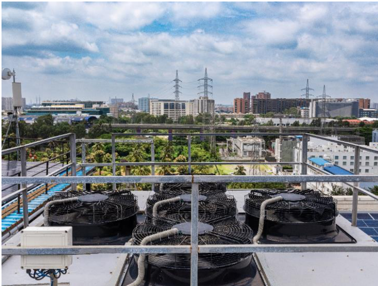
Bild 1: Seit 2016 wurden bereits über 1.000 hocheffiziente EC-Ventilatoren an den unterschiedlichen Anlagen und Standorten eingebaut.
