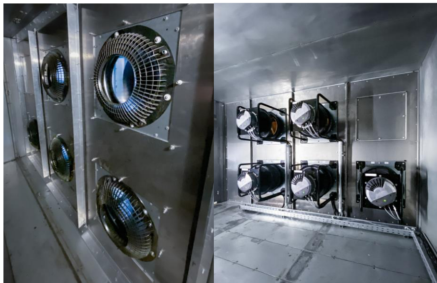
Bilder 2 und 3: Das FanGrid wurde so ausgelegt, dass sich jederzeit einfach ein weiterer Ventilator einbauen lässt. Die dafür vorgesehene Öffnung ist mit einer Klappe verschlossen. Die fünf RadiPac C EC-Ventilatoren sorgen für die nötige Redundanz der Anlage.
