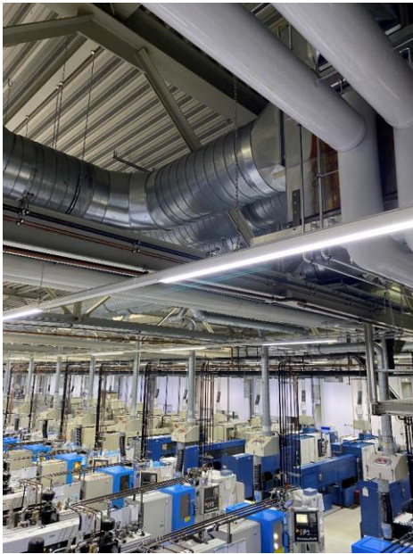
Bild 1: In Halle 2 ist die Maschinenabluft an die Lüftungsanlage gekoppelt. Das stellt besondere Anforderungen an deren Betriebssicherheit.
