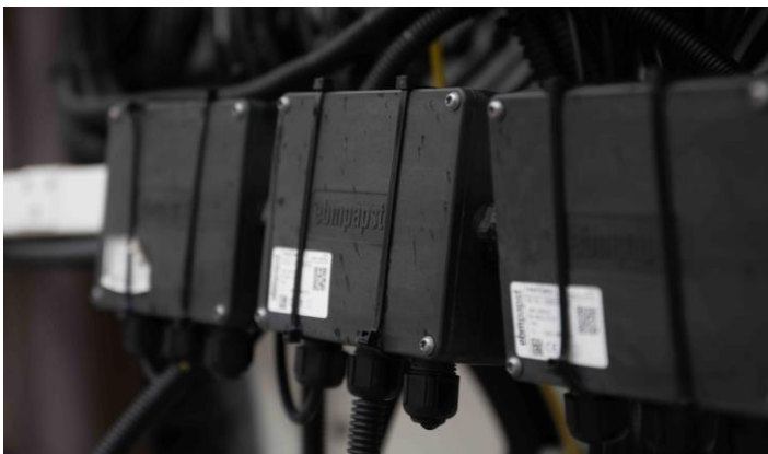
Bild 2: Bei den Gateways laufen alle Daten der neuen Sensoren zusammen und werden in die epCloud hochgeladen.
