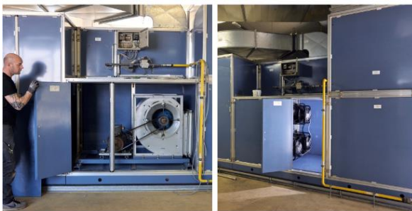
Bild 2: Die alten Ventilatoren wurden durch ein FanGrid mit drei Radialventilatoren der neuesten RadiPac Generation ersetzt.
