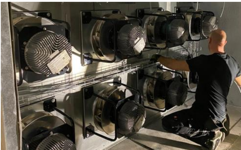
Bild 2: Im Automobilmuseum ZeitHaus reiht sich Fahrzeug an Fahrzeug. Die neue Lüftungsanlage tut es ihm nach einem Retrofit gleich: In einem FanGrid reiht sich RadiPac an RadiPac – und spart 25 % Energie ein. (Bild: ebm-papst)
