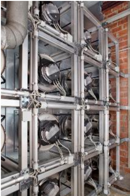
Bild 1: Ein FanGrid mit 16 Radialventilatoren von ebm-papst ersetzt den defekten alten Ventilator in der zentralen Lüftungsanlage des Shoppingcenters in Neckarsulm bei Heilbronn.
