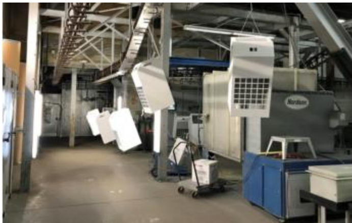
Bild 2: Mithilfe von Überstunden und Wochenendarbeit gelang es, die ersten Ventilatoren zusammen mit den Metallgehäusen innerhalb von zwei Wochen zu liefern.
