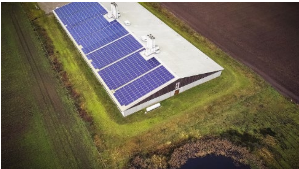
Bild 3: Der Schweinestall der Landwirte Momeyer bei Celle wurde mit neuen ebm-papst Ventilatoren für die Lüftung ausgestattet und spart nun über 50 % der Stromkosten.
