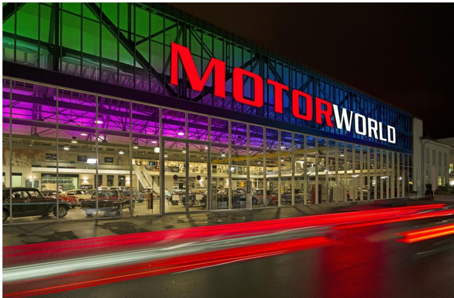
Bild 1: Die Motorworld in Böblingen ist die Location des ersten ebm-papst TGA-Fachplaner-Tages.
