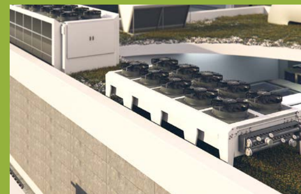
Remplacement par des ventilateurs axiaux EC
