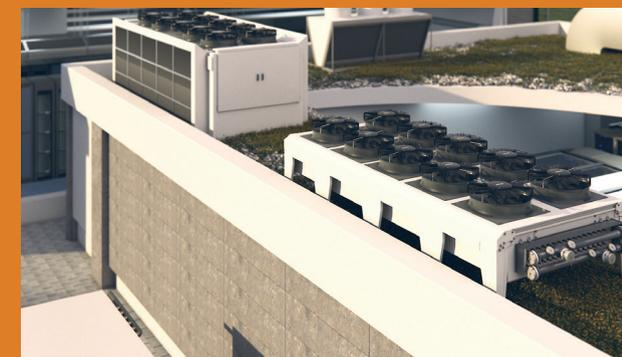
Remplacement par des ventilateurs axiaux EC
